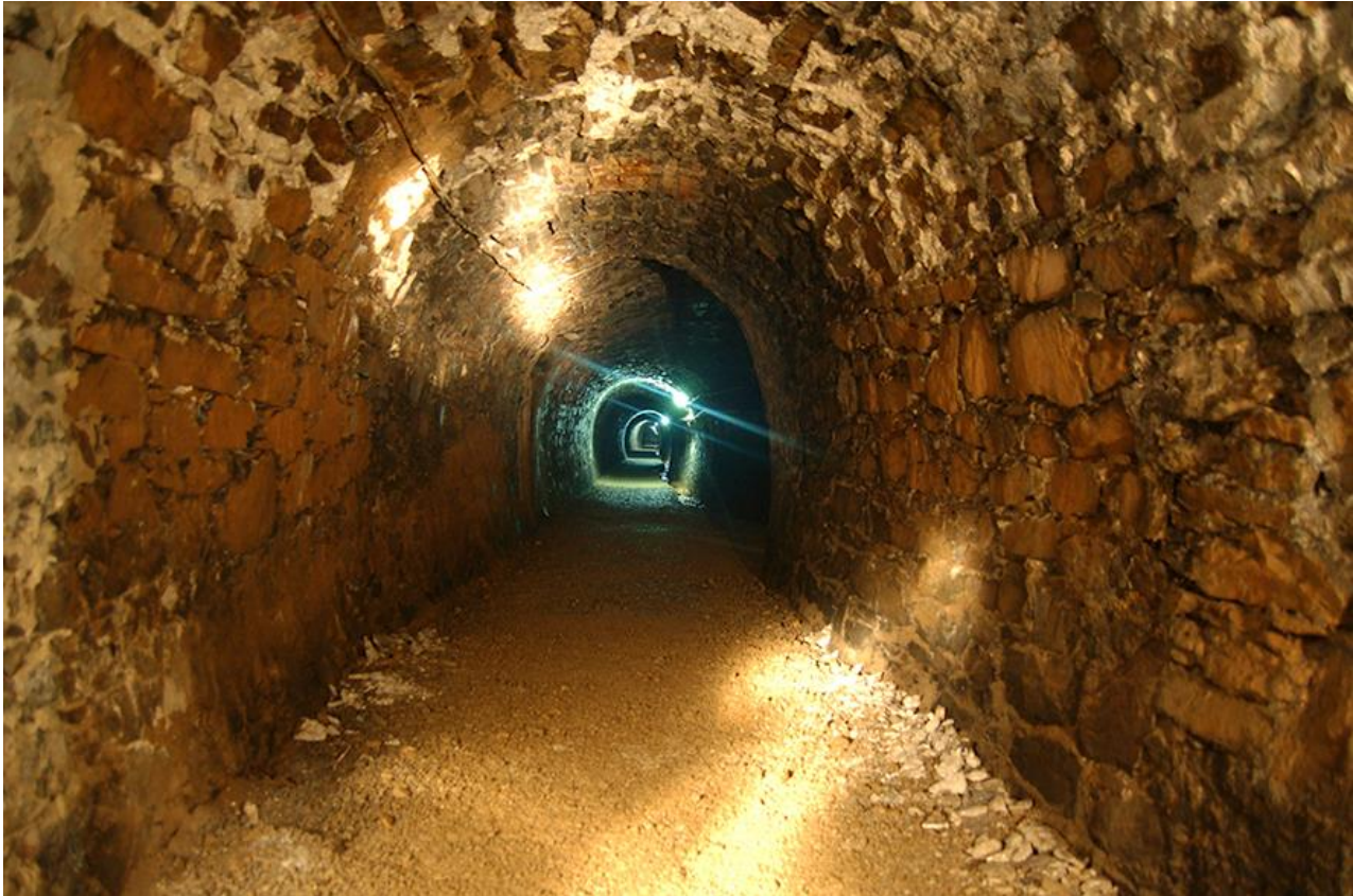
Fig. 1 – Una veduta della galleria Anglosarda. Miniera di Montevecchio. (Foto Comune di Guspini, E. Gola)
